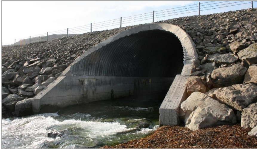
Mynd 6.8.3. Þverá í Vatnsfirði, stálræsi með steiptum undirstöðum og hálfhring yst (mynd: Aron Bjarnason, 2014).
